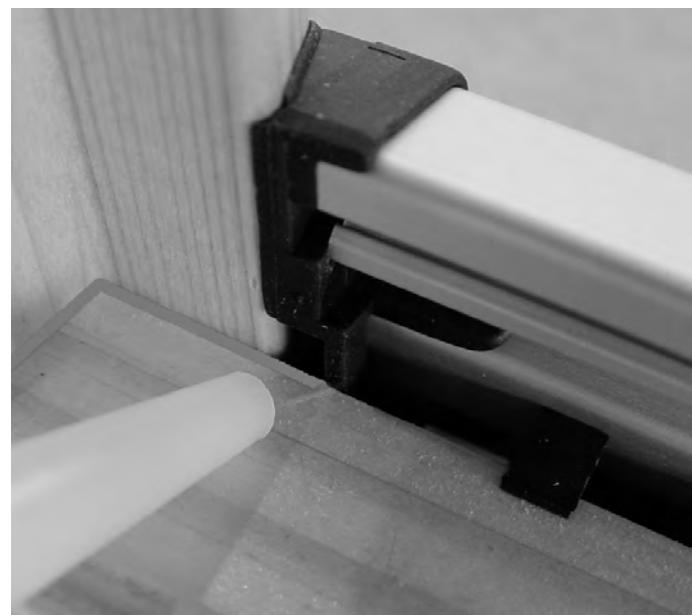
Angeformte Dichtstoffkanäle vereinfachen die Abdichtung der Endkappe zum Holzblendrahmen.
