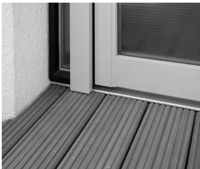
Türschwellen von BUG sind auf die Falzbereiche 19, 22 und 25 abgestimmt und eignen sich bei entsprechender Einbaulage für die Anforderung nach DIN 18025 für barrierefreies Wohnen.
